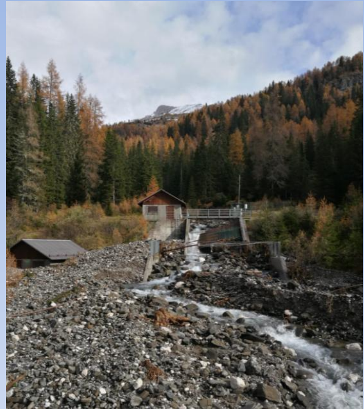
Foto piazza di deposito e canale di uscita dopo l'evento del 28-29/10/2018
