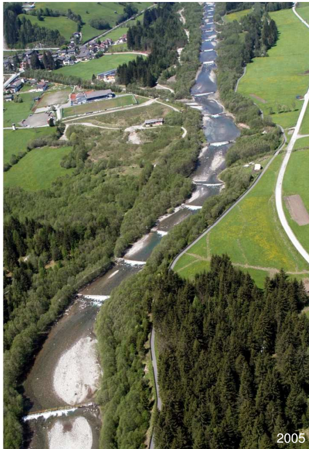
Prima dei lavori
