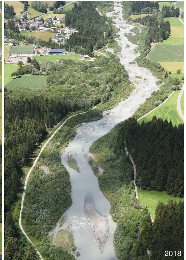
8 anni dopo i lavori
